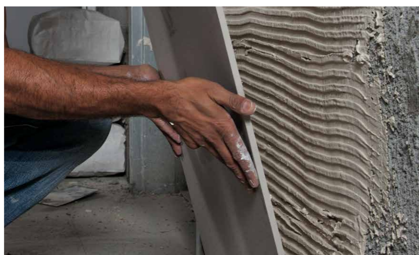
יישום שכבת הדבק במערכת להדבקות פנים בסירוק באמצעות דבק צמנטי בשיטת "רטוב על רטוב". צילום: דניאל לילה
