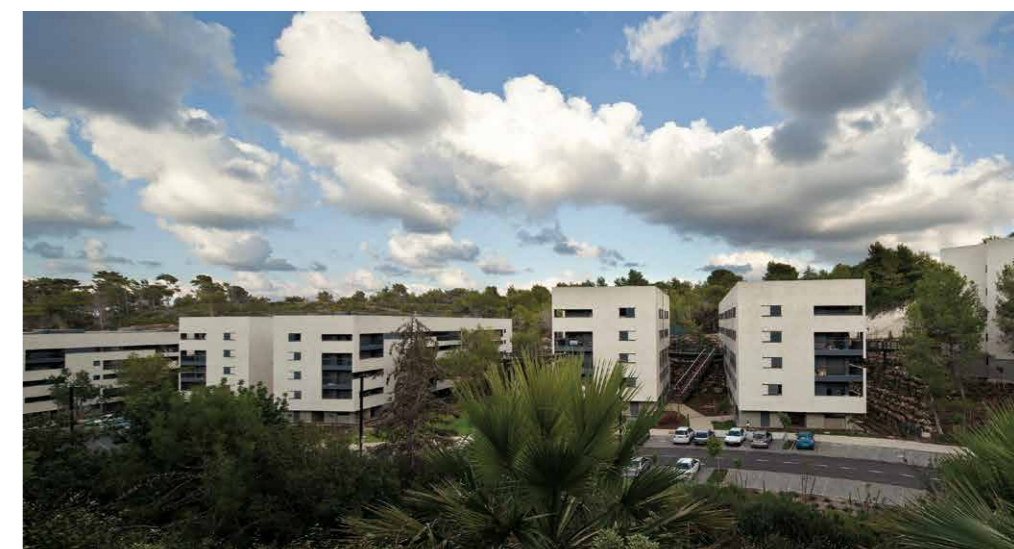
כפר המשתלמים בטכניון. מערכת הכוללת טיח תרמי עם גמר מינרלי בטקסורה רחוצה. תרמוקיר. אדריכלים: שוורץ-בסנטוסוף אדריכלים ובר-אוריין אדריכלים. צילום: עמית גרון
