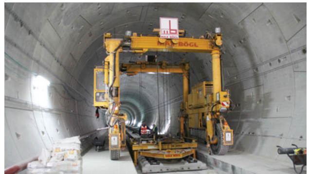
מיסעות הבטון מונחות באמצעות מנוף שער מנהרתי. תמונה באדיבות אלקטרה
